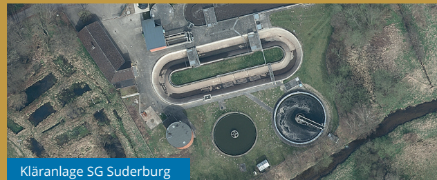
Kläranlage SG Suderburg
